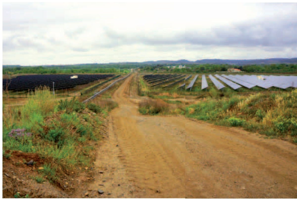
Centrale de Thézan-lès-Béziers.
